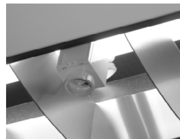
Helligkeitssensor in einer Büroleuchte
