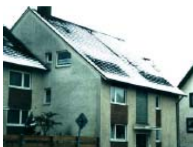
Ungedämmte Abseiten
