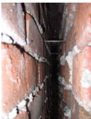
Abb. 2.1.2.3-4 Luftschichtmauerwerk Einblick in den 8 cm breiten Luftspalt
