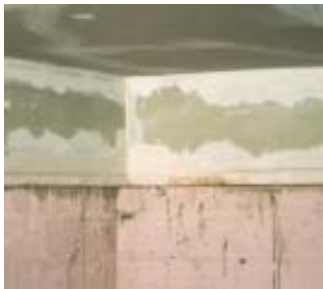
Abb. 2.1.1.4.3-8 Unterseitige Dämmung einer Beton-Kellerdecke mit PS-Hartschaumplatten
