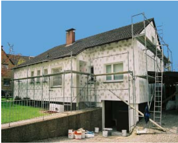
Abb. 2.1.2-4 Typische Außendämmung eines Hauses mit einschaligem Mauerwerk
