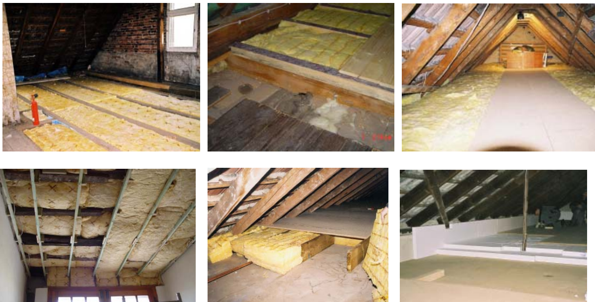
Ab. 2.1.4.2-7 Dämmung von Kehlbalkendecken - Ausführungsvarianten
