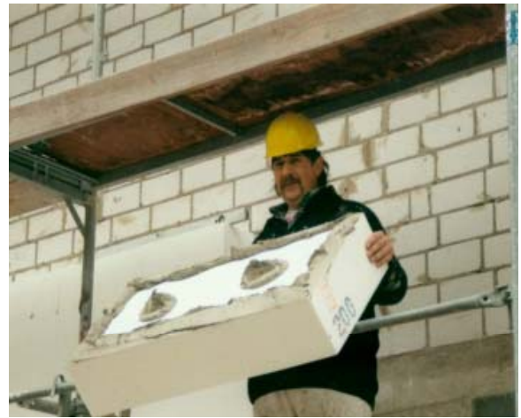
Abb. 2.1.2-5 Richtige Verklebung der Dämmplatten mit umlaufendem Wulst wg. Luftkammern
