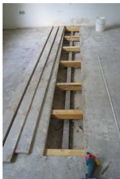
Abb. 2.1.1.4.2-2 Stahlträger-Kappendecken oberseitig teilgeöffnet für Einblasdämmung
