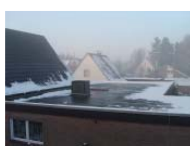
Nicht mehr wirkende Alt-Dämmung evtl. wg. Durchfeuchtung
