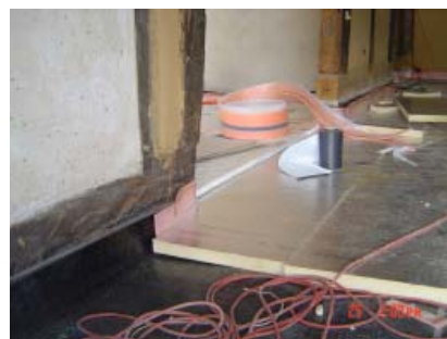
Abb. 2.1.1.1-3 Absenkung einer raumweisen Sohlplatte mit neuer Dämmung in einem Fachwerkhause mit oberseitig 6 cm PU-Hartschaum
