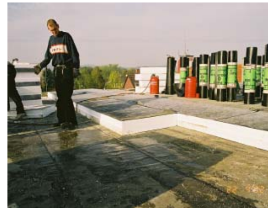
Beton-Fachdachsanierung von oben (24 cm)
