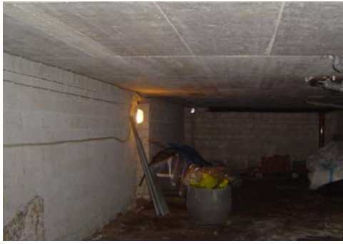
Abb. 2.1.1.4.3-6 Betondecke über Kriechkeller vor der Dämmung
