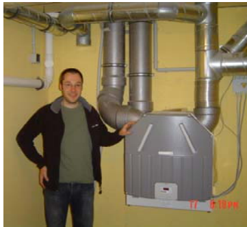
Abb. 2.1.5-7 Lüftungsanlage mit WRG in einem besonders Energiesparenden Neubau in Rheda
