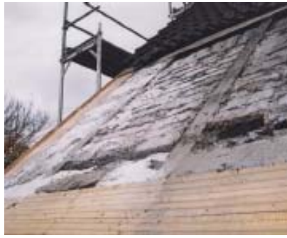
Schrägdach mit Leichtsteinfüllung
