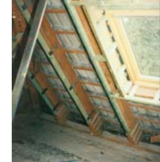
Schrägdachdämmung von innen mit innerer Sparrenaufdoppelung
