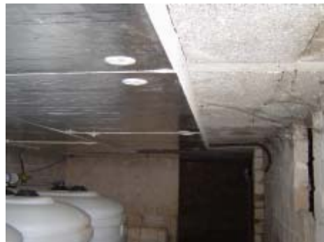
Abb. 2.1.1.4.3-9 Unterseitige Dämmung einer Beton-Kellerdecke mit PU-Hartschaumplatten
