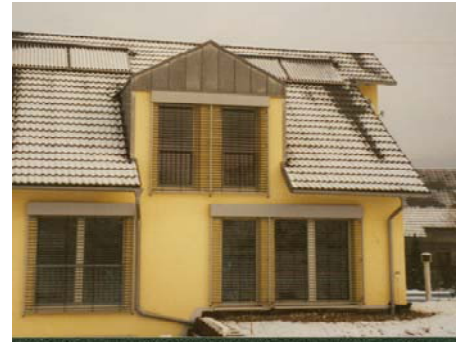
Halbgeschlossene Außenjalousien behindern solare Warmegewinne
