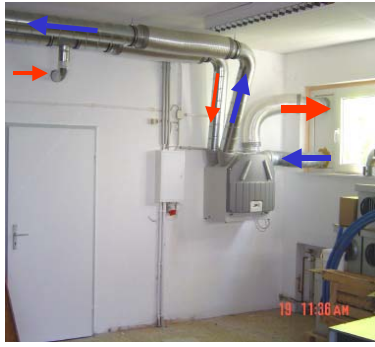
Abb. 2.1.5-6 Nachträglich eingebaute Lüftungsanlage mit WRG in einem Büroanbau mit Gewerberaum am Rand der Detmolder Innenstadt
