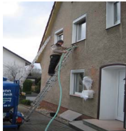
Abb. 2.1.2.3-6 Luftschichtmauerwerk Einblasen des Dämmstoffs
