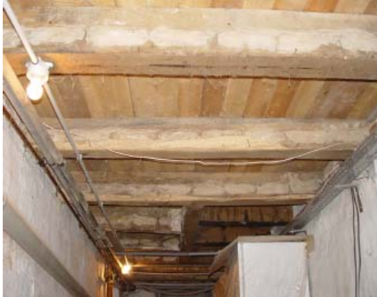
Abb. 2.1.1.4.1-3 Von unten geöffnete Holzbalken-Kellerdecke, in die von unten Dämmstoff eingebaut werden soll
