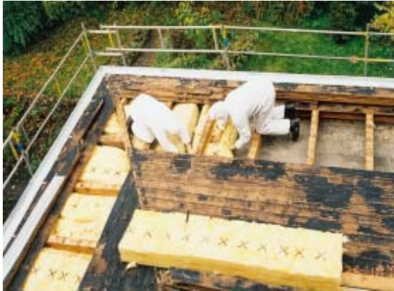
Holz-Kaltdachsanierungen von oben
