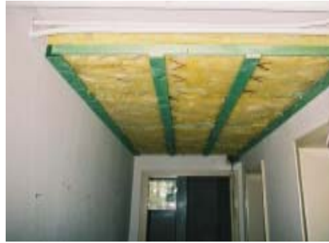
Abb. 2.1.1.4.3-7 Unterseitige Dämmung einer Beton-Kellerdecke in Leichtbauweise
