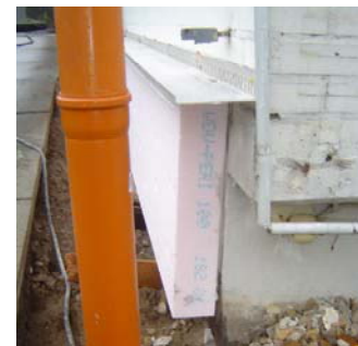
Abb. 2.1.1.2-4 Außendämmung nur des luftberührten Sockelbereichs als Mindestdämmung der Oberkante der Kellermauer
