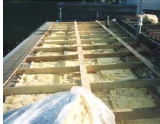
Holz-Kaltdachsanierungen von oben
