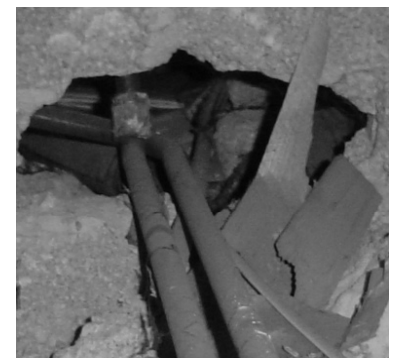
Abb. 2.2-1 Wärmeverluste durch ungedämmte Leitungen in einer ungedämmten Abseite
