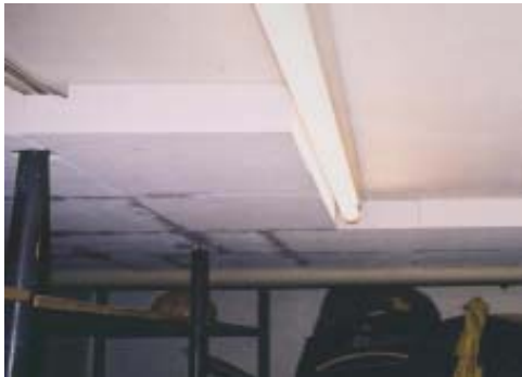
Abb. 2.1.1.4.3-8 Unterseitige Dämmung einer Beton-Kellerdecke mit PS-Hartschaumplatten
