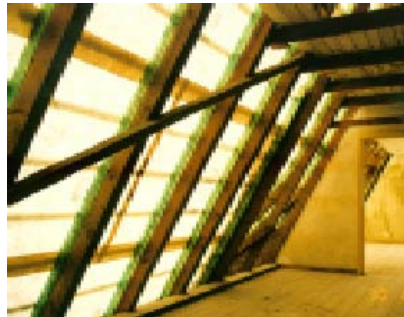
Schrägdach mit beiderseitiger Öffnung und Sparrenaufdoppelung
