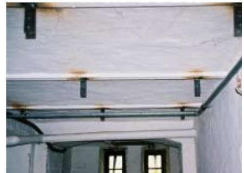
Abb. 2.1.1.4.2-4 Stahlträger-Kappendecke mit unterseitig angeschweißten Haltelaschen für die Traglatten einer unterseitigen Dämmkonstruktion
